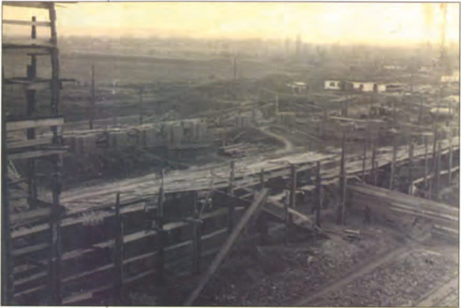
Будівництво стін цукрозаводу, 1949 рік. Державний музей історії Олександрівського району.
